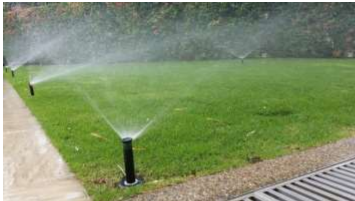
Figura 230: Detalhes de um spray escamoteável utilizado em paisagismo com diferentes padrões de distribuição de água.
