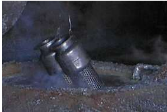
Figura 238: Processo de zincagem a quente com sistema vertical (Fonte: KREBSFER, 2016).
