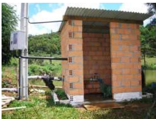
Figura 55: Casa de motobomba movida à energia elétrica em propriedade rural (Fonte: ANTUNES, 2006).
