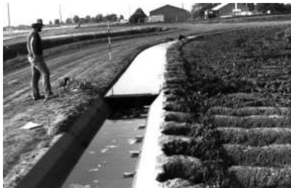
Figura 42: Sistema de irrigação por sulcos utilizando canal de concreto com saídas laterais em operação.
