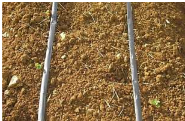
Figura 147: Tubo emissor com gotejador tipo labirinto integrado instalado em campo (Fonte: ANTUNES, 2006).
