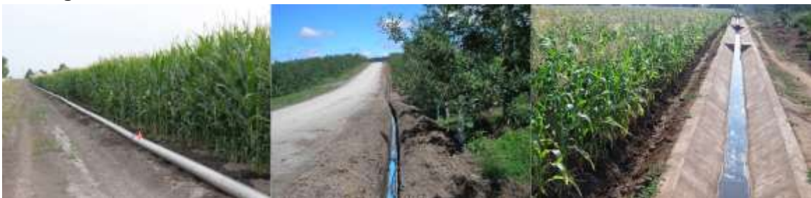
Figura 13: Exemplos de unidades de distribuição de água em sistemas de irrigação: tubos metálicos (a esquerda), tubos plásticos (centro) e canais de concreto (a direita).
