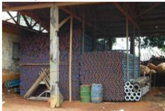
Figura 243: Tubos de PVC armazenados em pilhas com altura excessiva.
