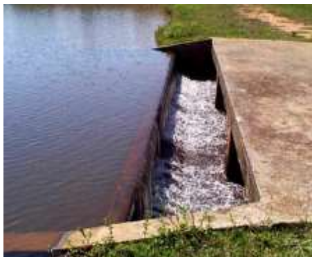
Figura 263: Vertedouro de barragem construída para atender demandas de irrigação.
