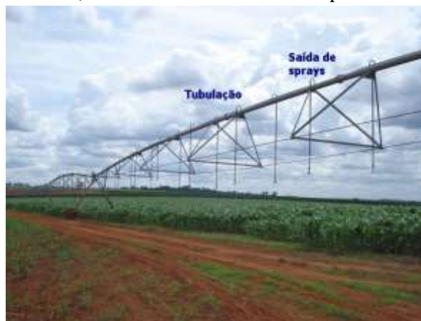
Figura 83: Detalhe da tubulação de aço zincado com conexões franjeadas.
