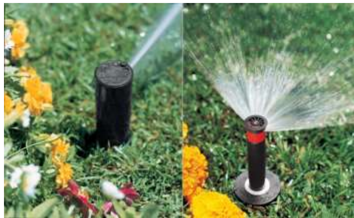
Figura 228: Exemplo de aspersor escamoteável utilizado em paisagismo: rotativo (esquerda) e estacionário (direita).
