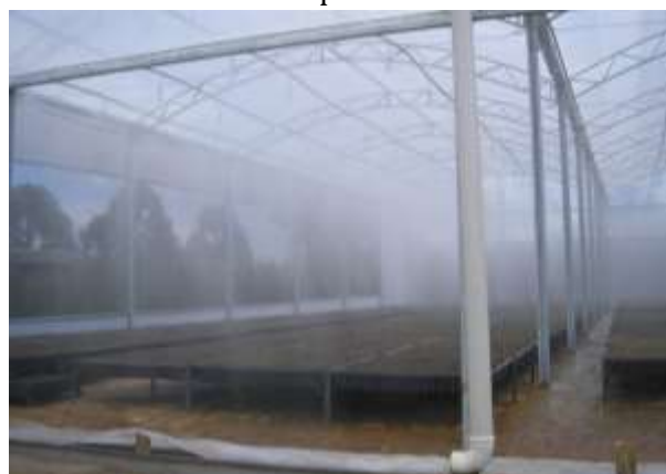
Figura 216: Sistema de nebulização em estufas
