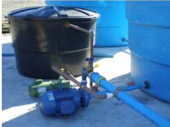
Figura 224: Sistema de fertirrigação utilizando bomba injetora centrífuga (Fonte: ANTUNES, 2006).
