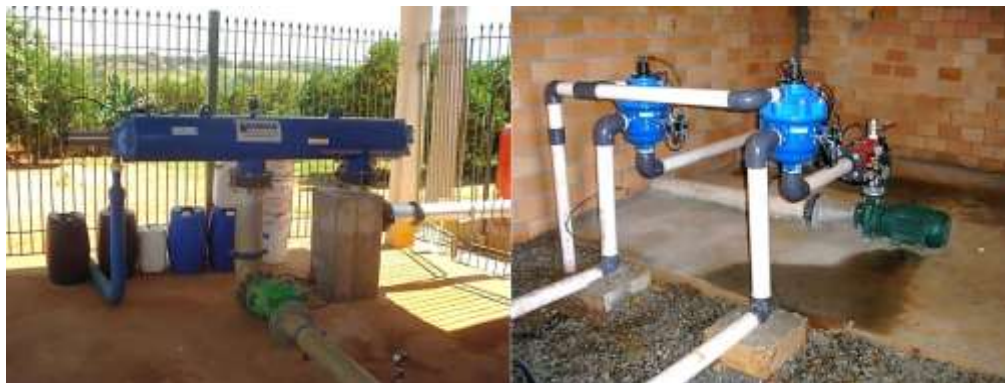
Figura 128: Exemplos de filtros automatizados: tela (esquerda) e disco (direita).
