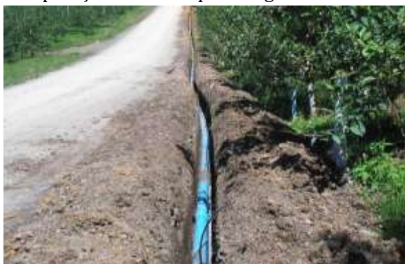
Figura 134: Detalhe da instalação da linha principal enterrada com tubulação de PVC (Fonte: ANTUNES, 2006).
