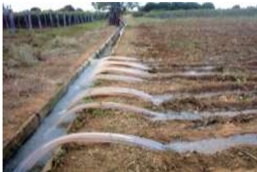
Figura 41: Canal operando com vários sifões em seção do canal controlada por comporta.
