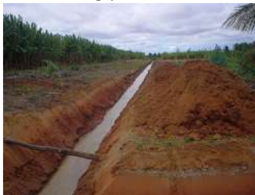
Figura 27: Exemplo de canal de drenagem utilizado em sistemas de irrigação por superfície.
