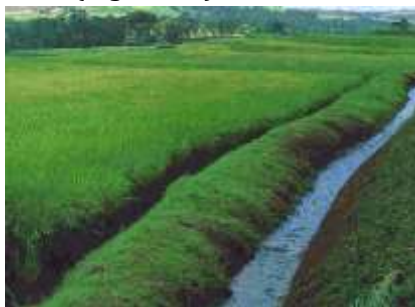
Figura 29: Exemplo da altura de diques e da área ocupada por canais.
